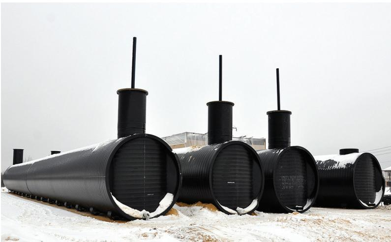
Комплекс резервуаров (400 м<sup>3</sup>) для хранения воды хозяйственно-питьевого назначения. Микрорайон Новоугольный Тульской области, строительство водозаборного узла.
