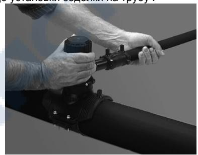
7. Сориентировать поворотный отвод и попеременно затягивать прижимные винты тройника до полной фиксации фитинга.
