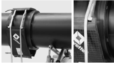
10. Вставить в муфту вторую трубу до нанесенной отметки. Аналогично, если в сечении трубы наблюдается явная овальность, принять меры по восстановлению цилиндричности. После этого наложить на муфту обжимные подушки, выровняв их по вырезу фитинга со стороны сварки. Произвести предварительную фиксацию обжимных подушек с помощью фиксирующих ремней.
