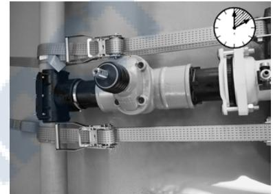
7. Прежде чем приступать к врезке, дождаться окончания минимального периода охлаждения сварного соединения.
