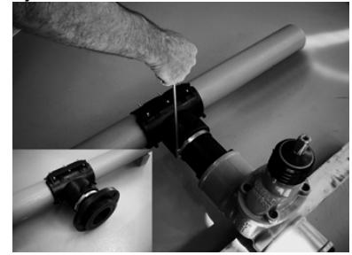
1. Протереть отводную трубу в месте сварки. При помощи поворотного зачистного инструмента равномерно снять оксидный слой полиэтилена, соблюдая требования к минимально допустимой толщине стенки трубы. Длина зачищенного участка должна быть не меньше глубины вставки отвода в седелку.
