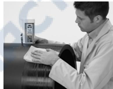
6. Обезжирить область сварки трубы при помощи чистой тканевой салфетки, пропитанной растворителем Tangit PE.
