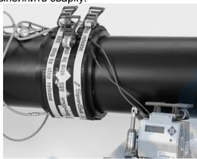
14. По завершении второй сварочной операции проверить показания на дисплее сварочного аппарата на предмет ошибок и отключить кабели. По завершении периода охлаждения сбросить давление в прижимных прокладках и снять весь обжимной комплект.
