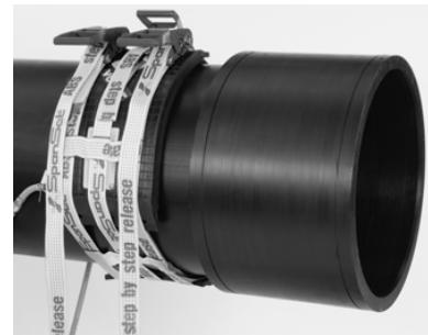
9. Вставить в муфту первую трубу до нанесенной отметки. В случае повышенной овальности трубы восстановить ее цилиндричность в соответствии с подробным "Руководством по установке муфт большого диаметра с помощью обжимного комплекта".
