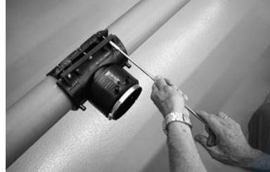
4. Установить отводную седелку на трубу и затянуть крепежные винты. Затягивать винты следует попеременно, до полного устранения зазора и обездвиживания седелки относительно трубы.
