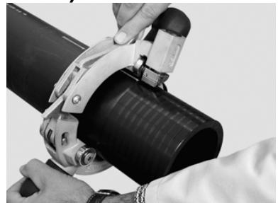
3. Протереть отводную трубу в месте сварки. При помощи поворотного зачистного инструмента равномерно снять оксидный слой полиэтилена, соблюдая требования к минимально допустимой толщине стенки трубы. Длина зачищенного участка должна быть не меньше глубины вставки отвода в седелку.
