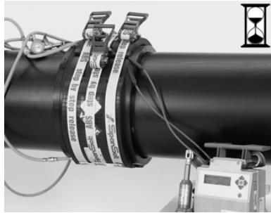
12. По завершении сварки проверить показания на дисплее сварочного аппарата на предмет ошибок, после чего отключить кабели. По завершении периода охлаждения сбросить давление в обжимных подушках и ослабить ремни. Длительность периода охлаждения приведена на магнитной карте, а также выводится на дисплее сварочного аппарата.
