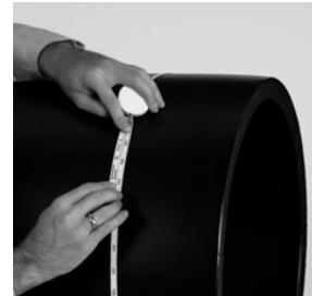
3. Измерить диаметр трубы про помощи гибкой измерительной ленты до зачистки и после нее. Минимально допустимый наружный диаметр составляет:
