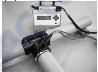
6. Произвести сварку согласно прилагаемой к сварочному аппарату инструкции. Следить за тем, чтобы отводная труба при этом оставалась на заданной глубине вставки.
