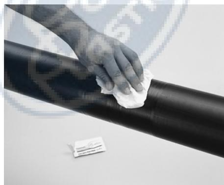
Обезжириванию подвергают только предназначенный для сварки защищенный участок трубы. При обработке участка большей площади возникает угроза переноса загрязнений на защищенный участок поверхности.
