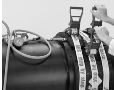
11. Наложить по центру обжимных подушек фиксирующие ремни. Для этого сначала полностью затянуть средний ремень, затем боковые. Подать воздух в подушки и довести давление в них до требуемого значения (более подробно эта процедура описана в "Руководстве по установке муфт большого диаметра с помощью обжимного комплекта"). Проверить правильность монтажа, после чего подключить сварочные кабели к разъемам на первой стороне муфты и выполнить сварку.
