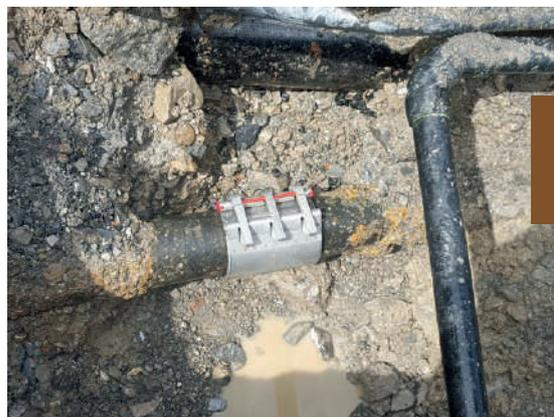
Поврежденная труба; быстрая и надежная герметизация при помощи муфты STRAUB-REP-FLEX .
