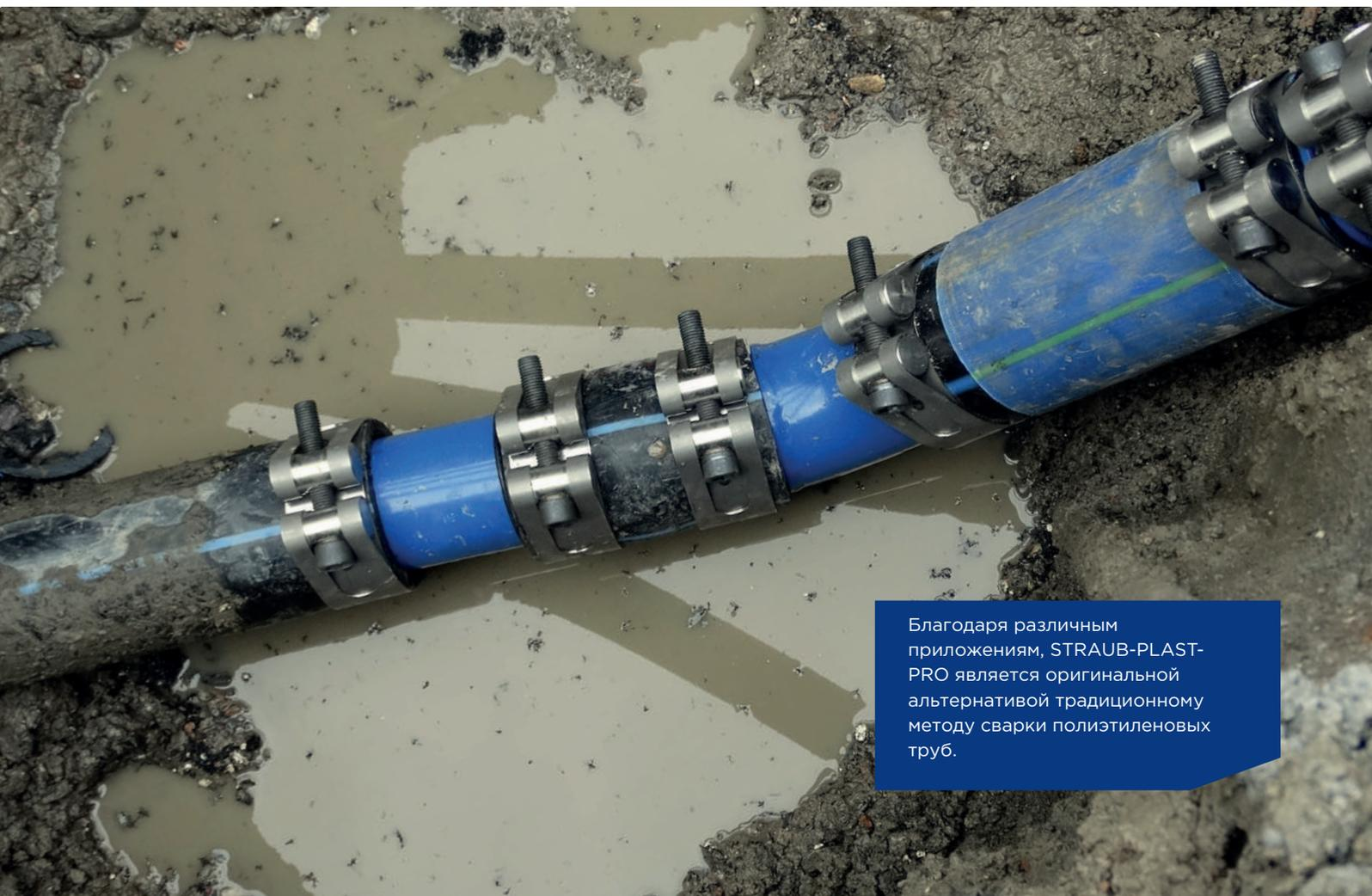
Благодаря различным приложениям, STRAUB-PLAST-PRO является оригинальной альтернативой традиционному методу сварки полиэтиленовых труб.
