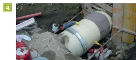
4. Наложите один слой ленты для защиты трубы, перекрывая защитную полосу примерно на 200 мм с обеих сторон. Несильно включив горелку, нагрейте поверхность под лентой и нажимайте для фиксации покрытия.
